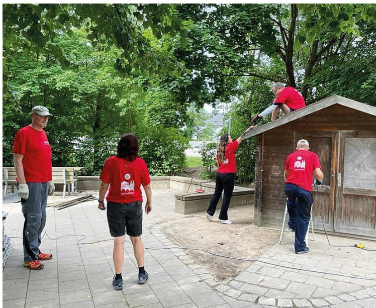
Auf dem Bild: Im Kinderhort „Zeitlerner Schlaufüchse“ wurden anstehende Arbeiten erledigt.
